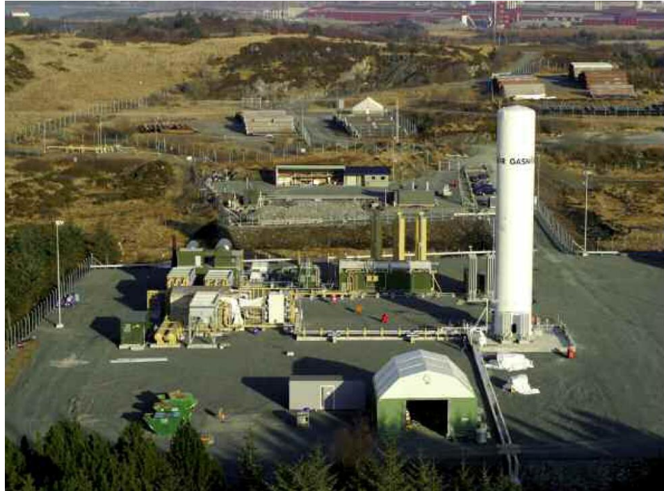
Figure 8 Snurrevarden Mini LNG plant in Norway
